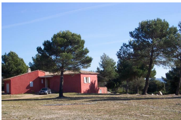
Exemple du débroussaillage obligatoire autour d'une habitation (Var – Signes) Sources : ONF, agence DFCI
